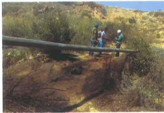
Fotografía N°1: Suelo impregnado de hidrocarburo 33 m 2
