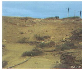
Fotografía N°2: Remediación de Área afectada
